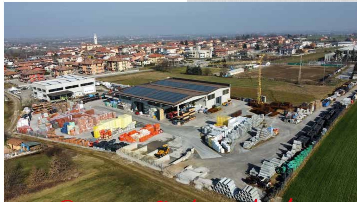
Pianfei Sede centrale
